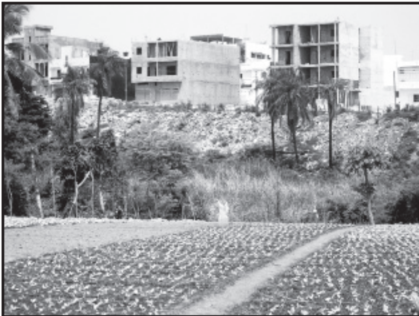
Des nouveaux logements construits sur des remblais de déchets sur ce qui était des parcelles maraichères à Dakar
